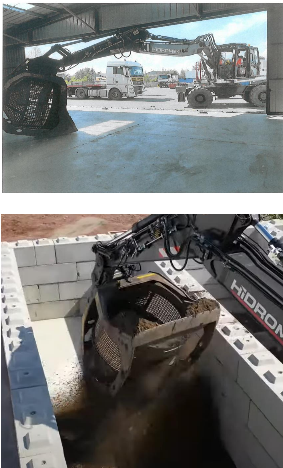
Figure 4. Opérations de criblage et d'homogénéisation des sédiments, dans les casiers de stockage
